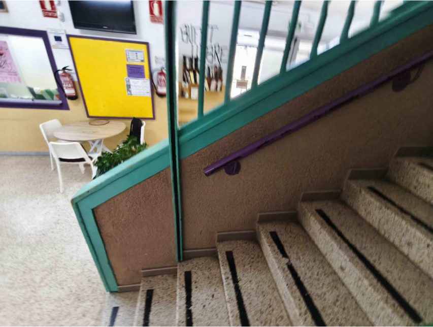
BARANA METÀL·LIC DE L'ESCALA (A DRETA I ESQUERRA, DES DE PL. BAIXA A PL. SEGONA).
