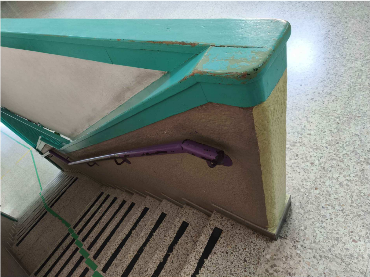
PASSAMÀ DE FUSTA SOBRE MURET D'OBRA A L'ESCALA (DES DE PL. BAIXA A PL. SEGONA).
